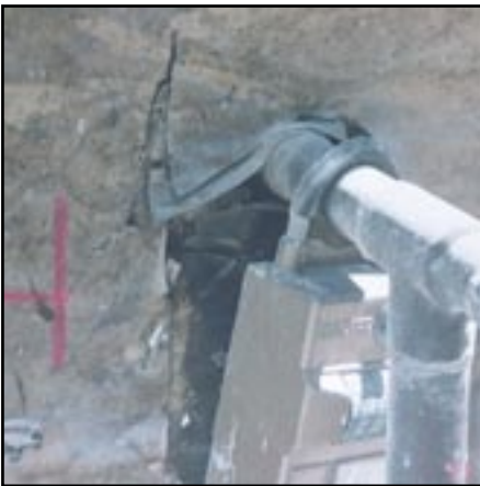
Gas conduit penetration
